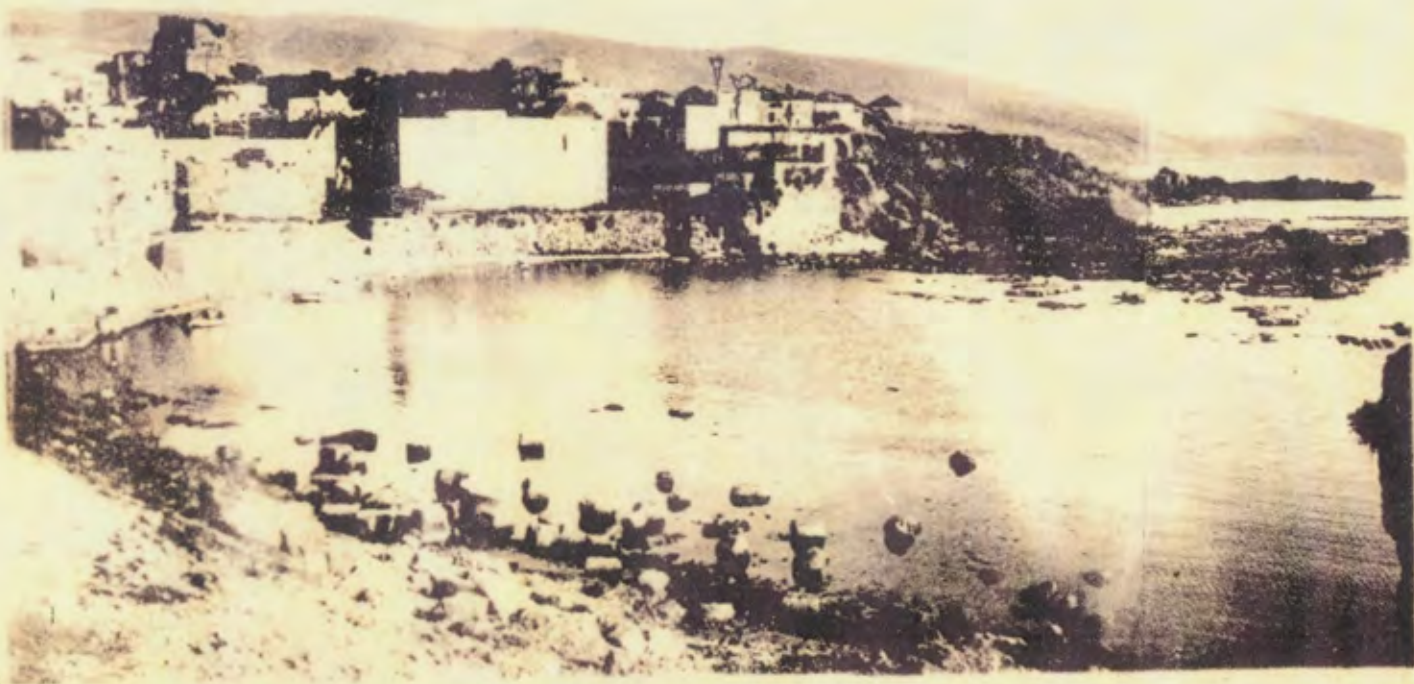
1. BYBLOS (Jebel) — Ancien port
